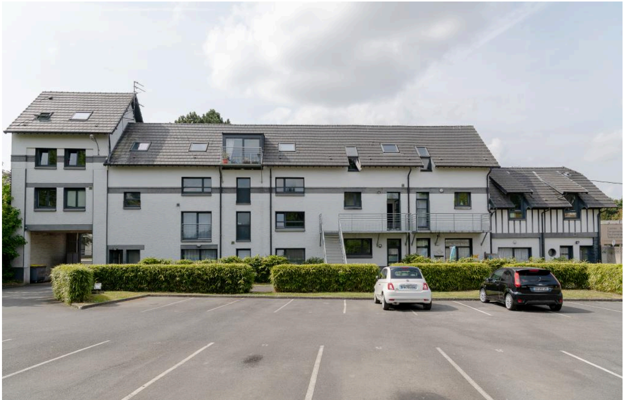
Vue de la façade sur cour de l'ancien immeuble de bureaux.
