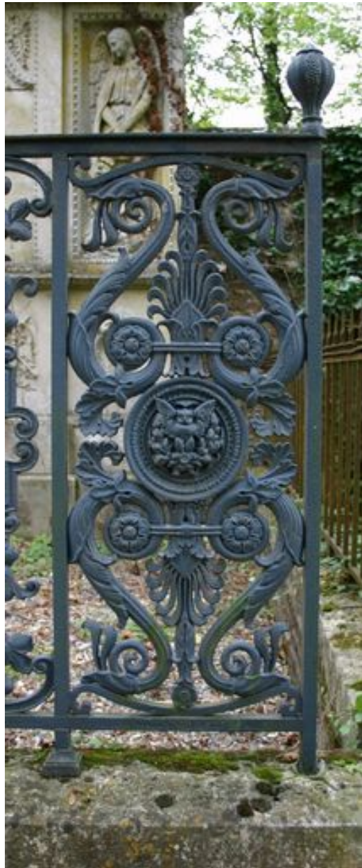
Détail de la grille de clôture ouvragée : face antérieure.
