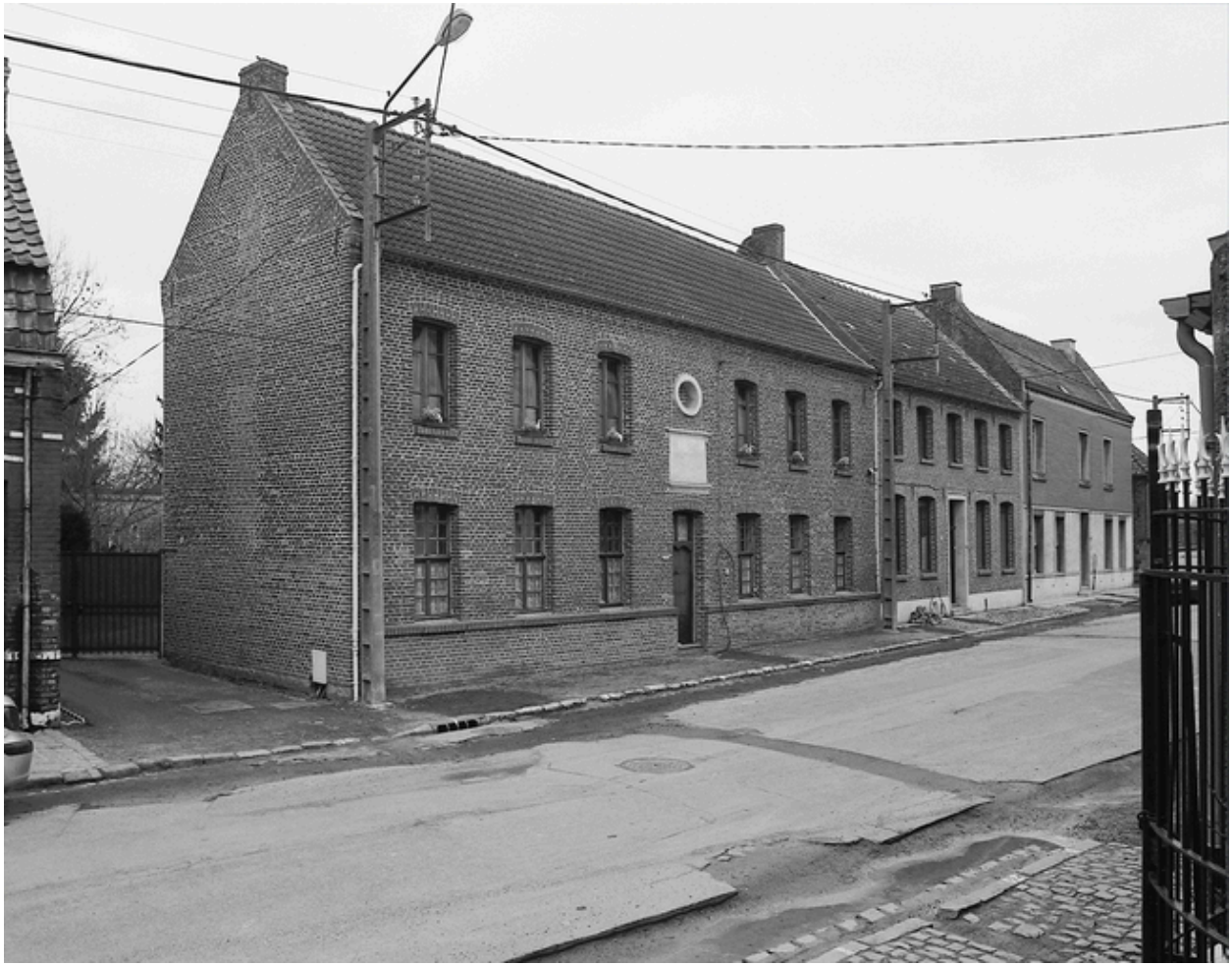
Maisons en alignement, rue de l'Eglise.
