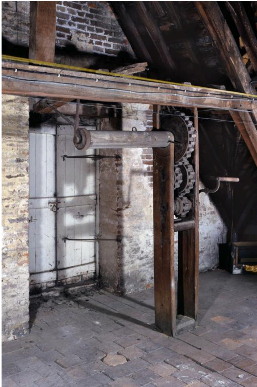
Vue du treuil situé dans les combles.
