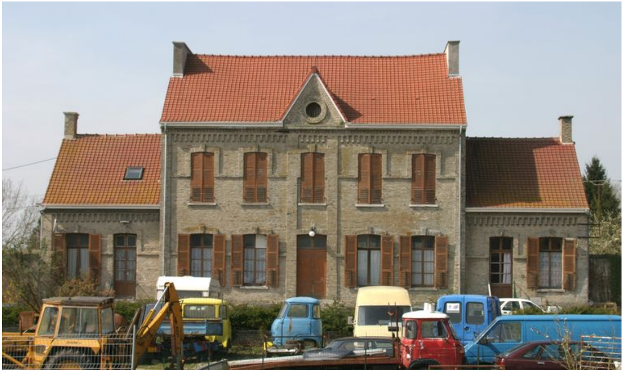
Vue du logis depuis l'est.
