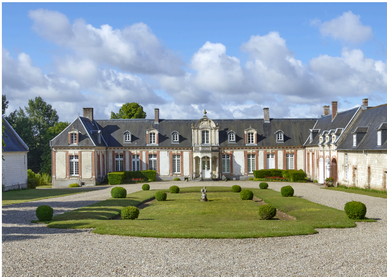
Vue de la façade nord du château, depuis la rue.
