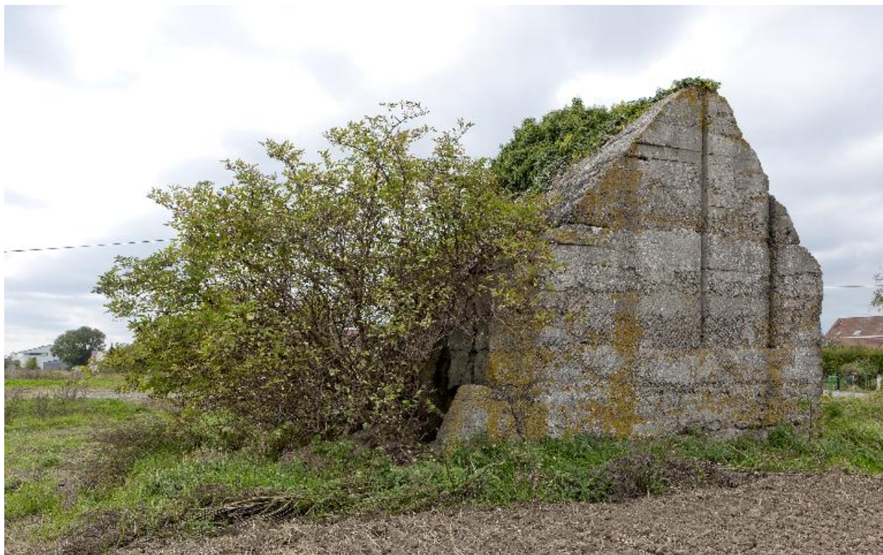
Vue vers le nord-ouest
