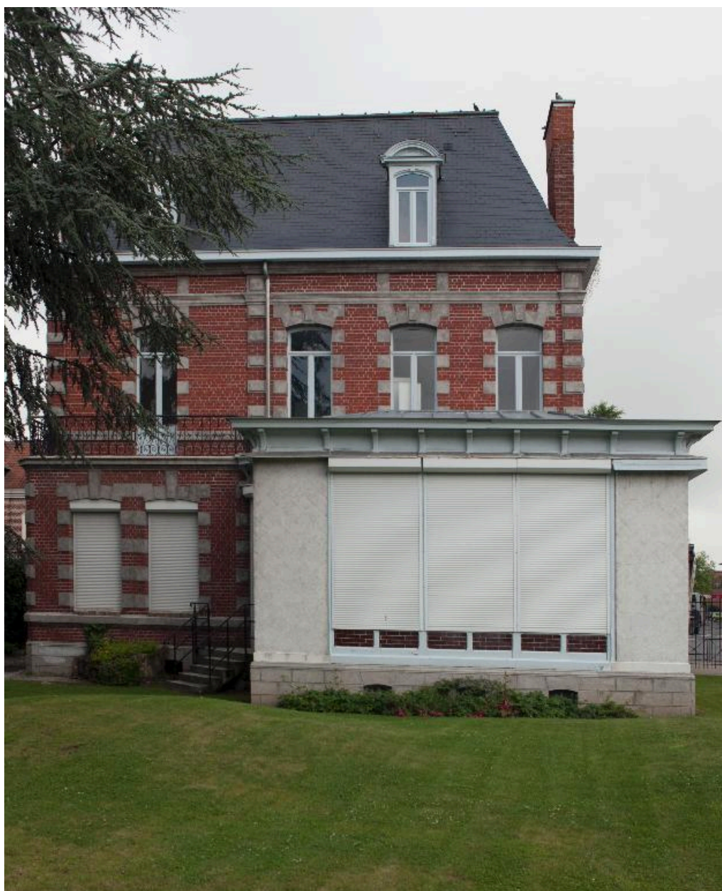
Vue générale de la façade postérieure.
