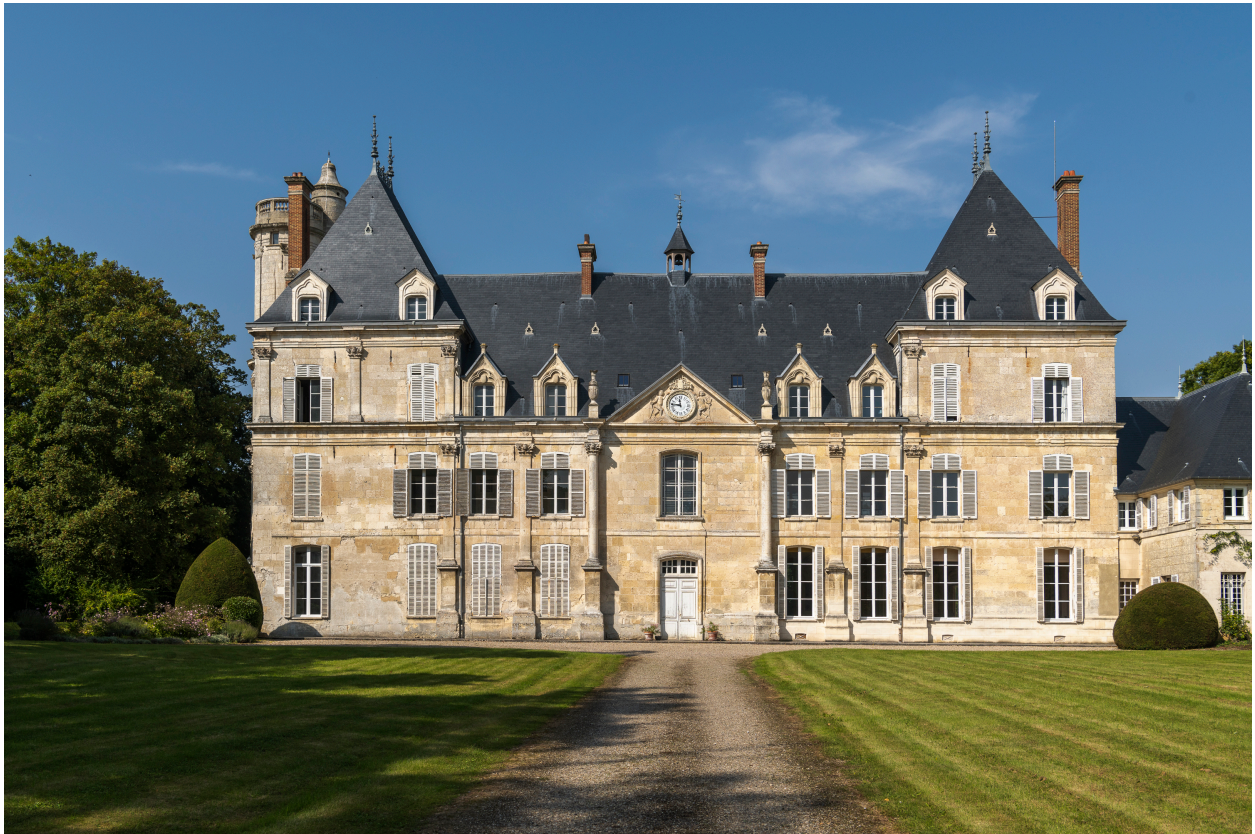
Corps principal, vue depuis le sud.
