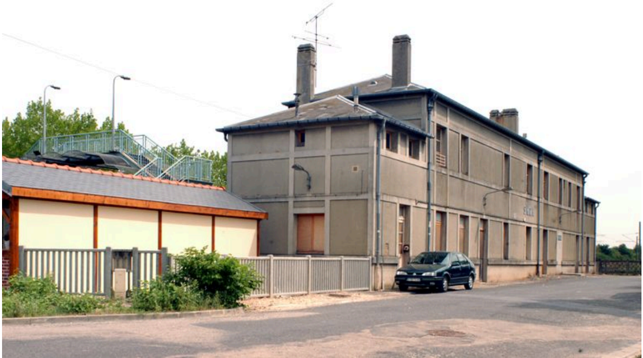
Vue générale depuis le nord-ouest.
