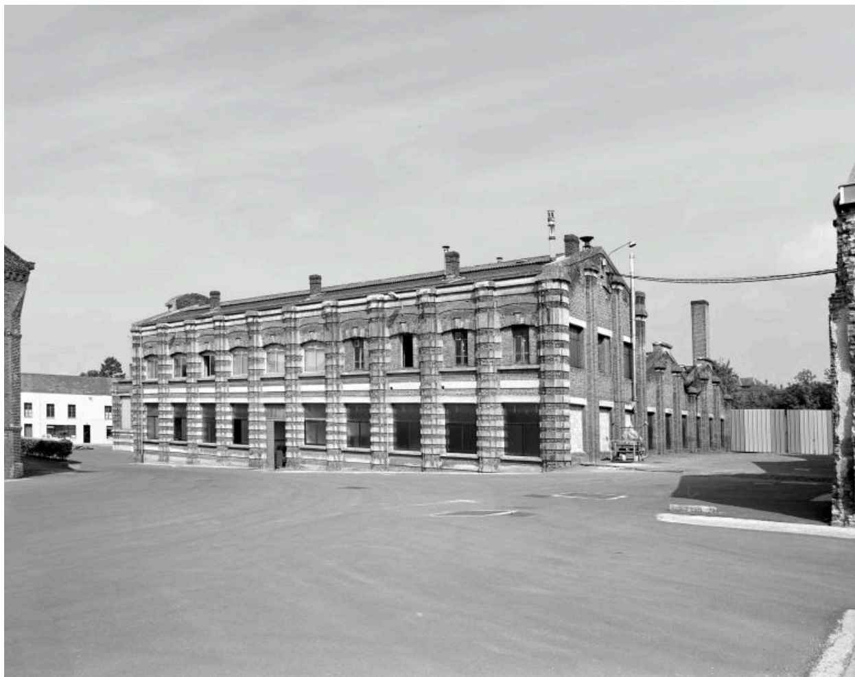
Vue de la façade latérale de l'atelier des modèles.
