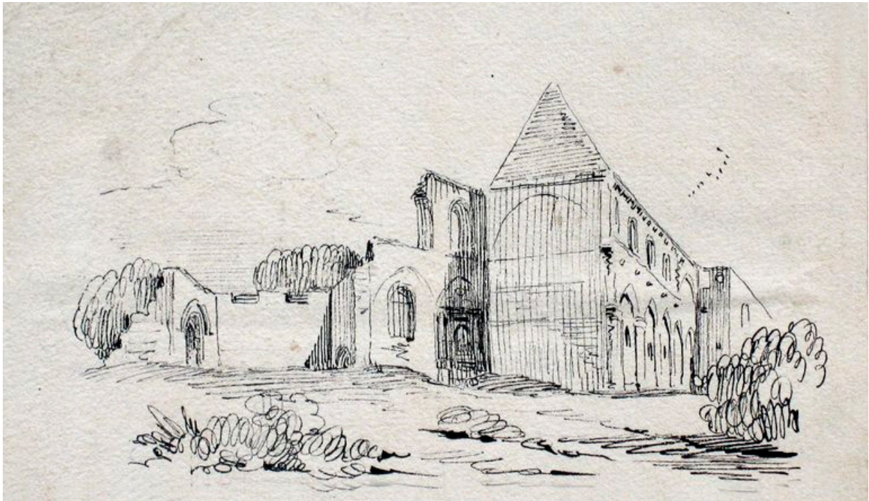
Flanc nord et vestiges du choeur, par Louis Duthoit, 1873 (AMH, Médiathèque de l'Architecture et du Patrimoine. Berteaucourt-lès-Dames ; 80/81).
