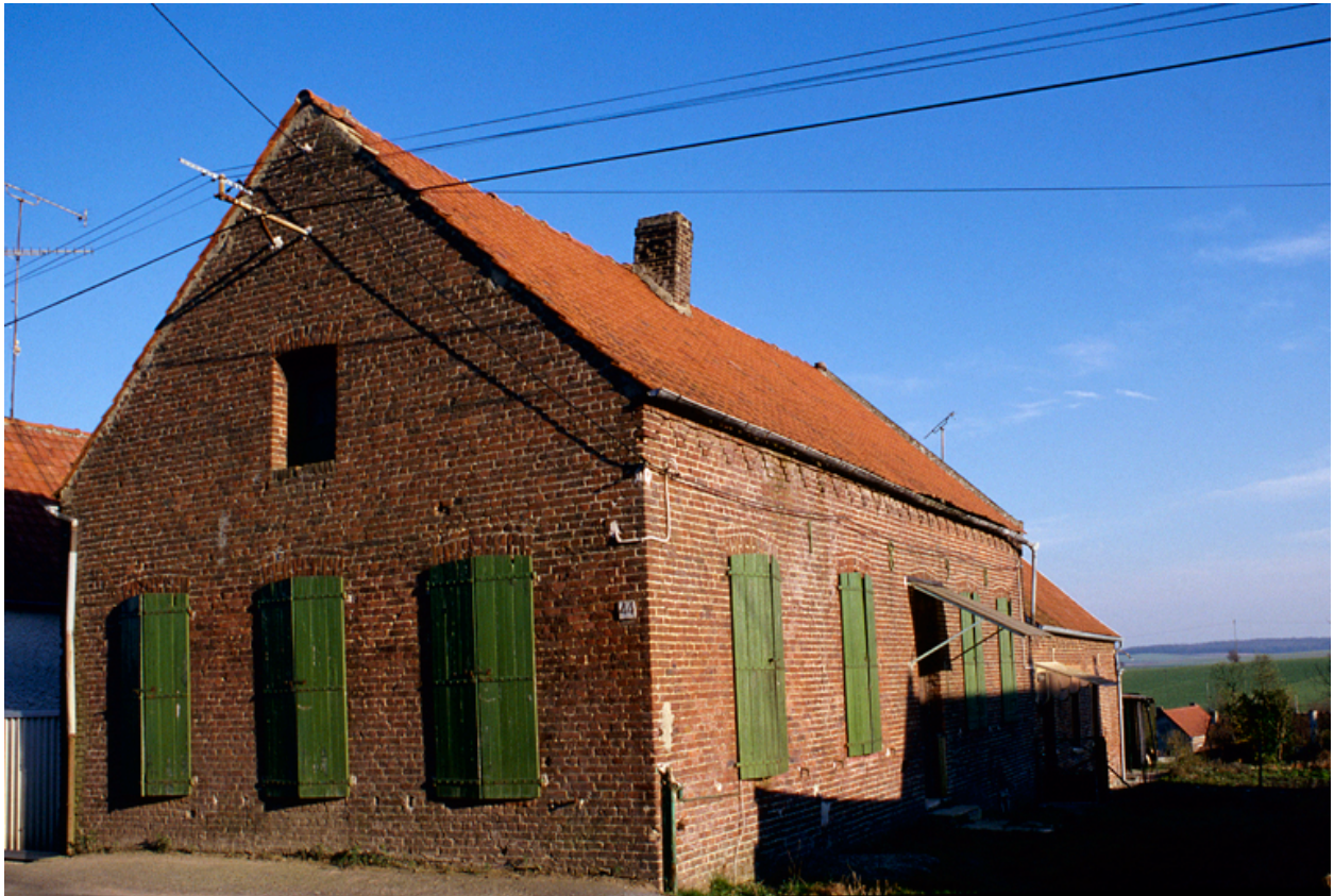
Vue d'ensemble nord-ouest de l'édifice daté de 1890.
