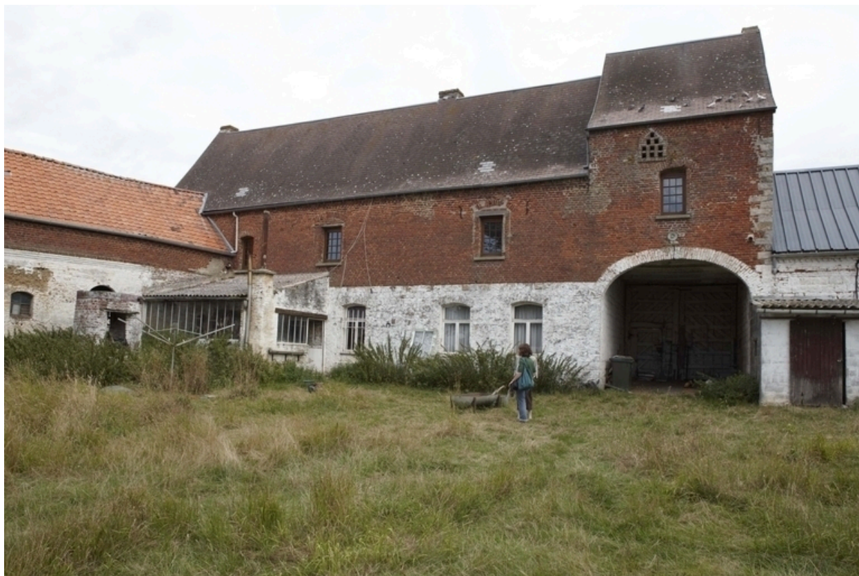
Vue de l'élévation sur cour du logis et du pigeonnier-porche.
