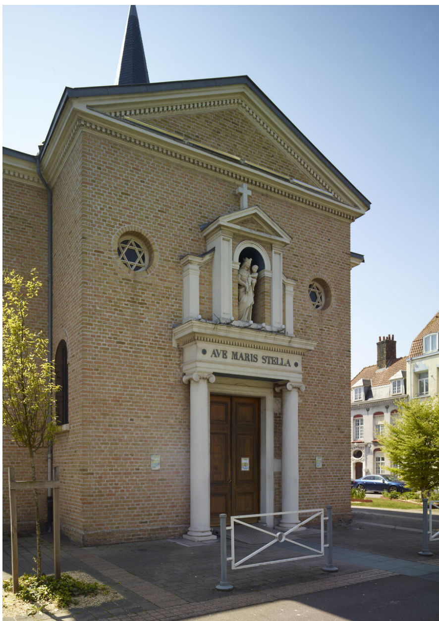
Vue générale de l'entrée, côté nord.
