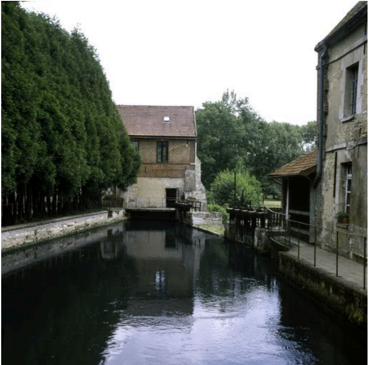
Vue du canal de dérivation et le moulin à farine, façade nord.
