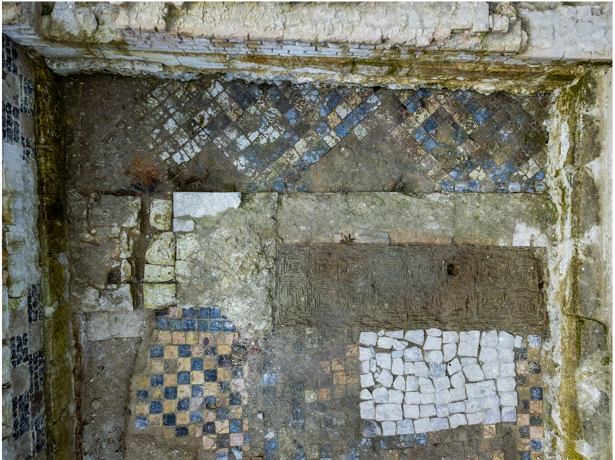
Pavements et cheminée monumentale (collection particulière).
