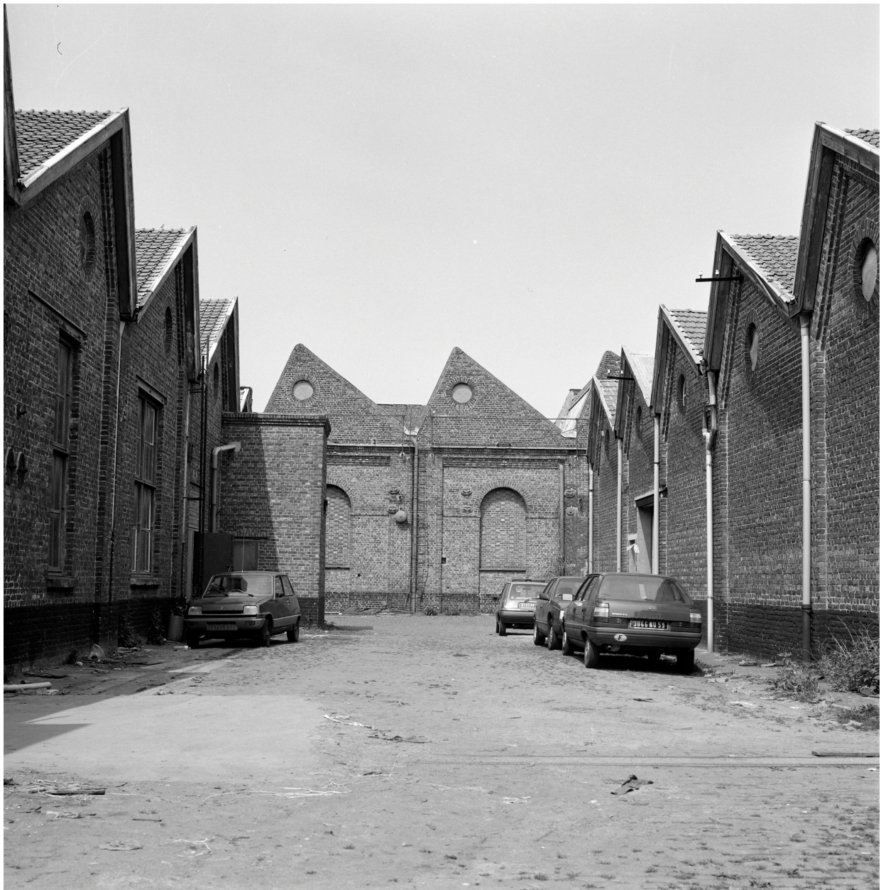
Vue prise vers le nord. À droite le tissage. À gauche l'ancienne retorderie. Au fond le magasin industriel.
