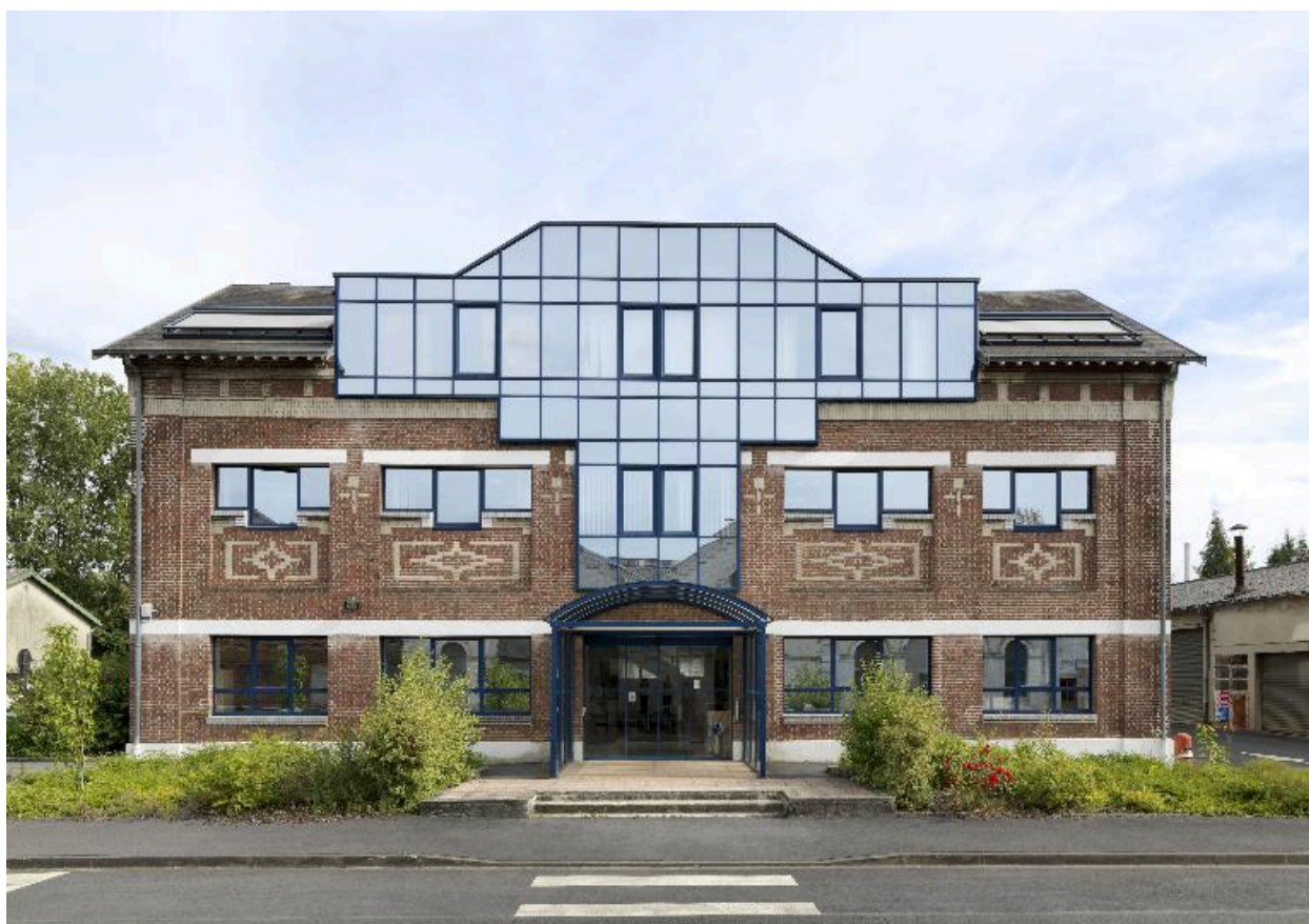
Bâtiment administratif, vue de face.
