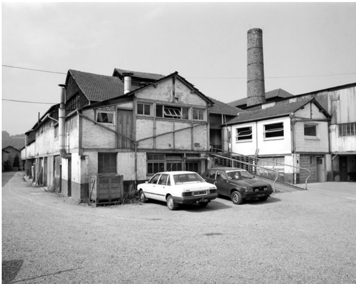
Atelier de fabrication, vue partielle, flanc nord est
