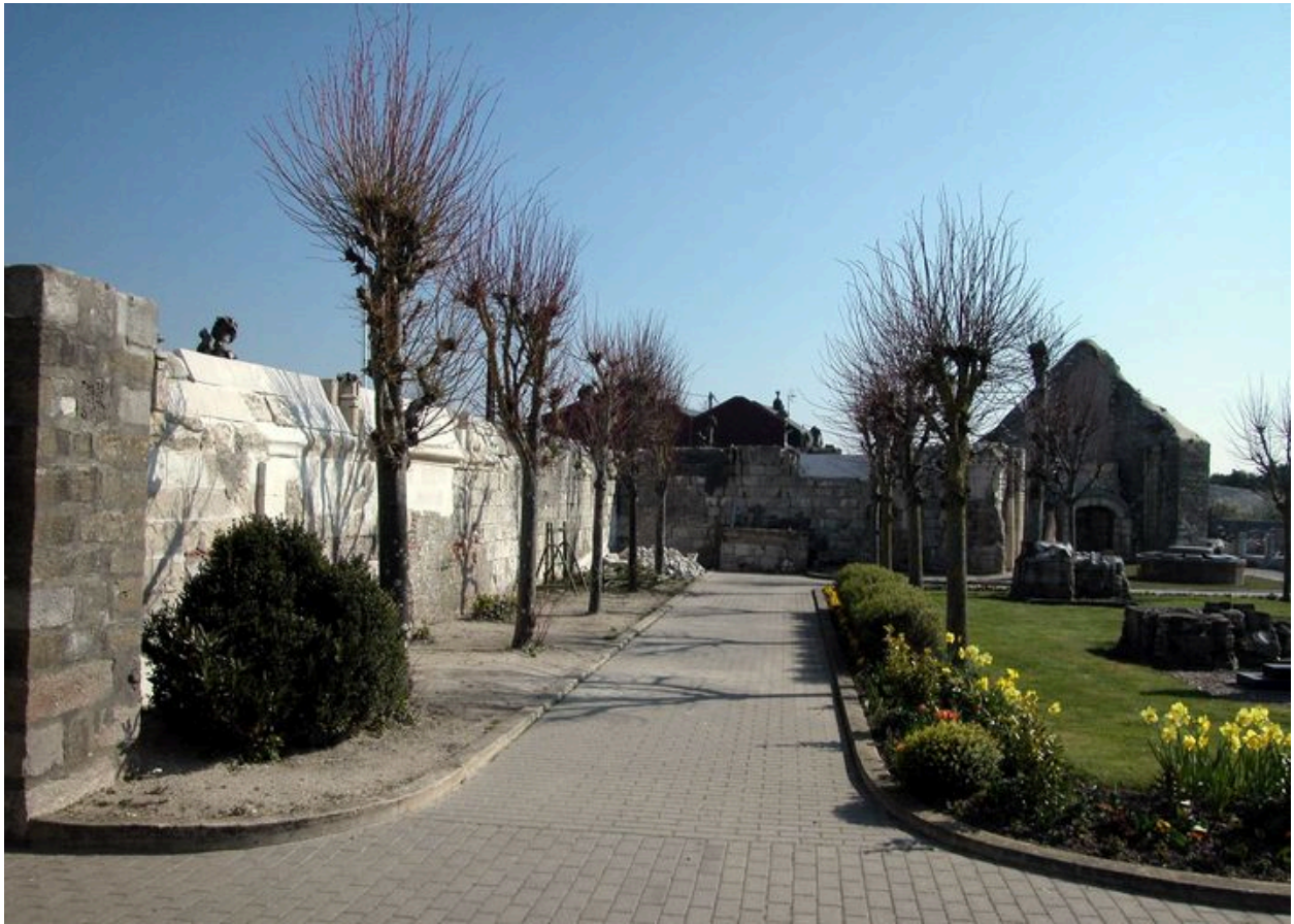
Vue de l'ancien bas-côté nord de l'église paroissiale en ruines.
