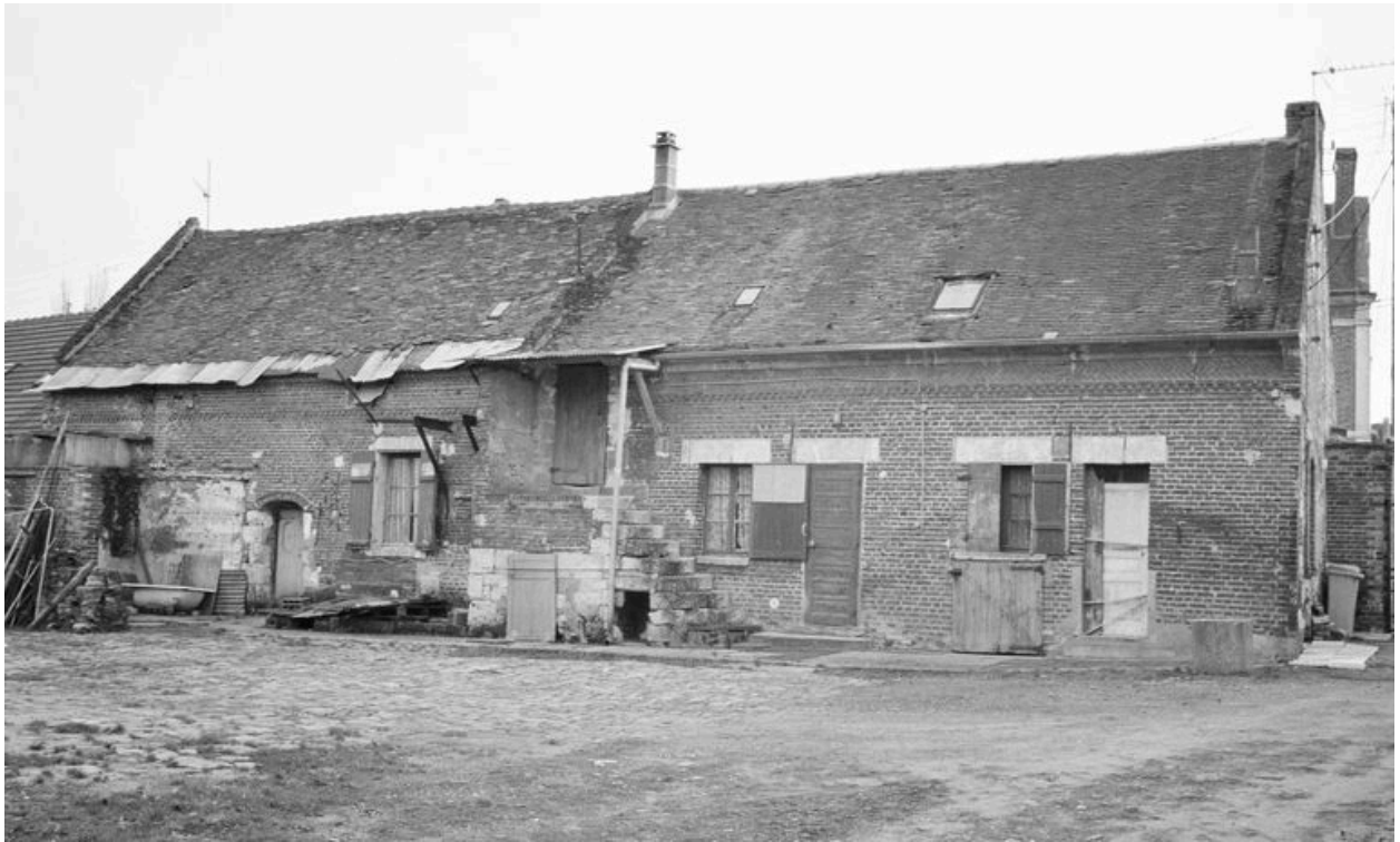
Maison de briquetier : façade sur cour.
