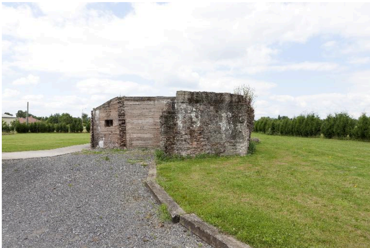
Pignon nord vers le sud-ouest
