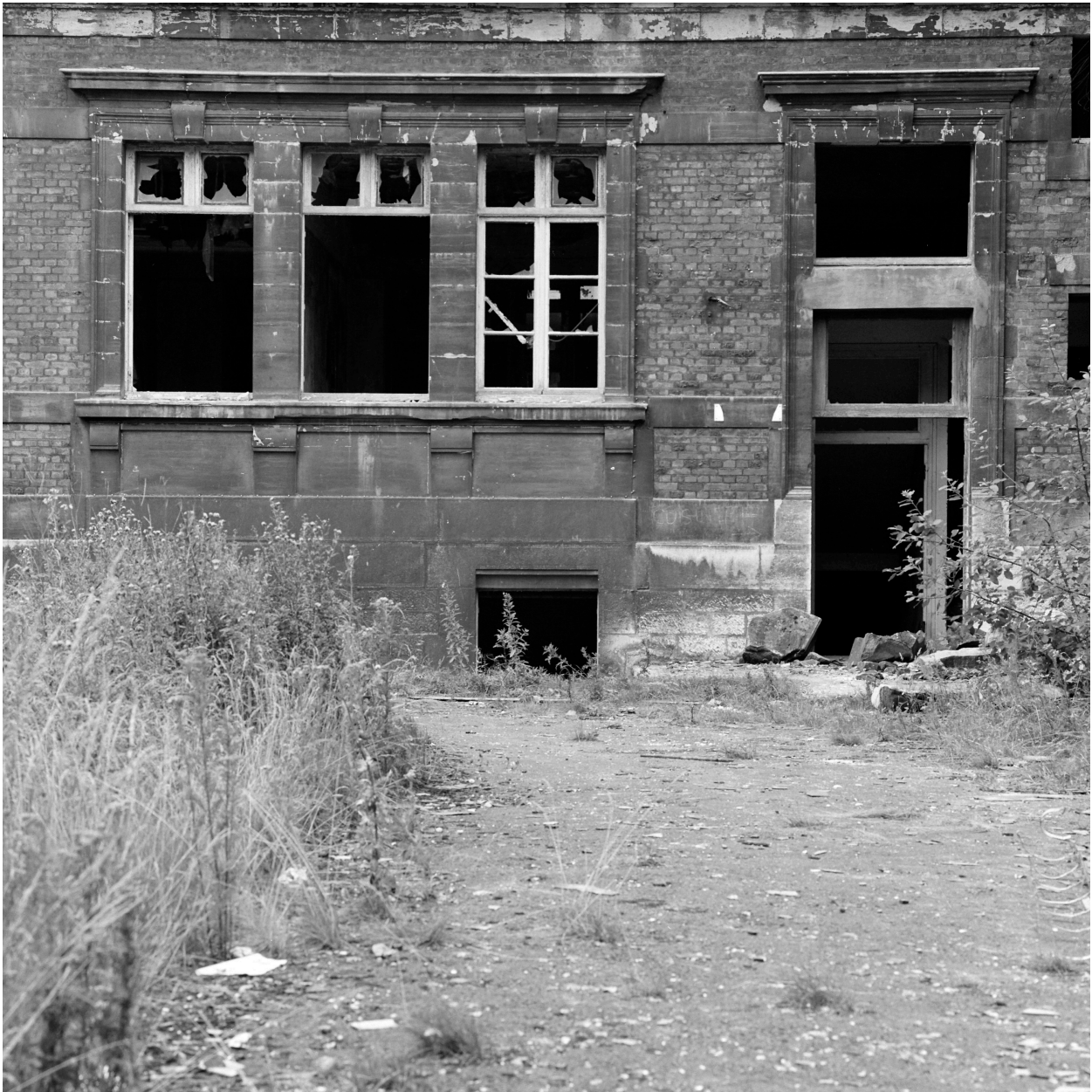
Bâtiment A, façade sur cour, baies.
