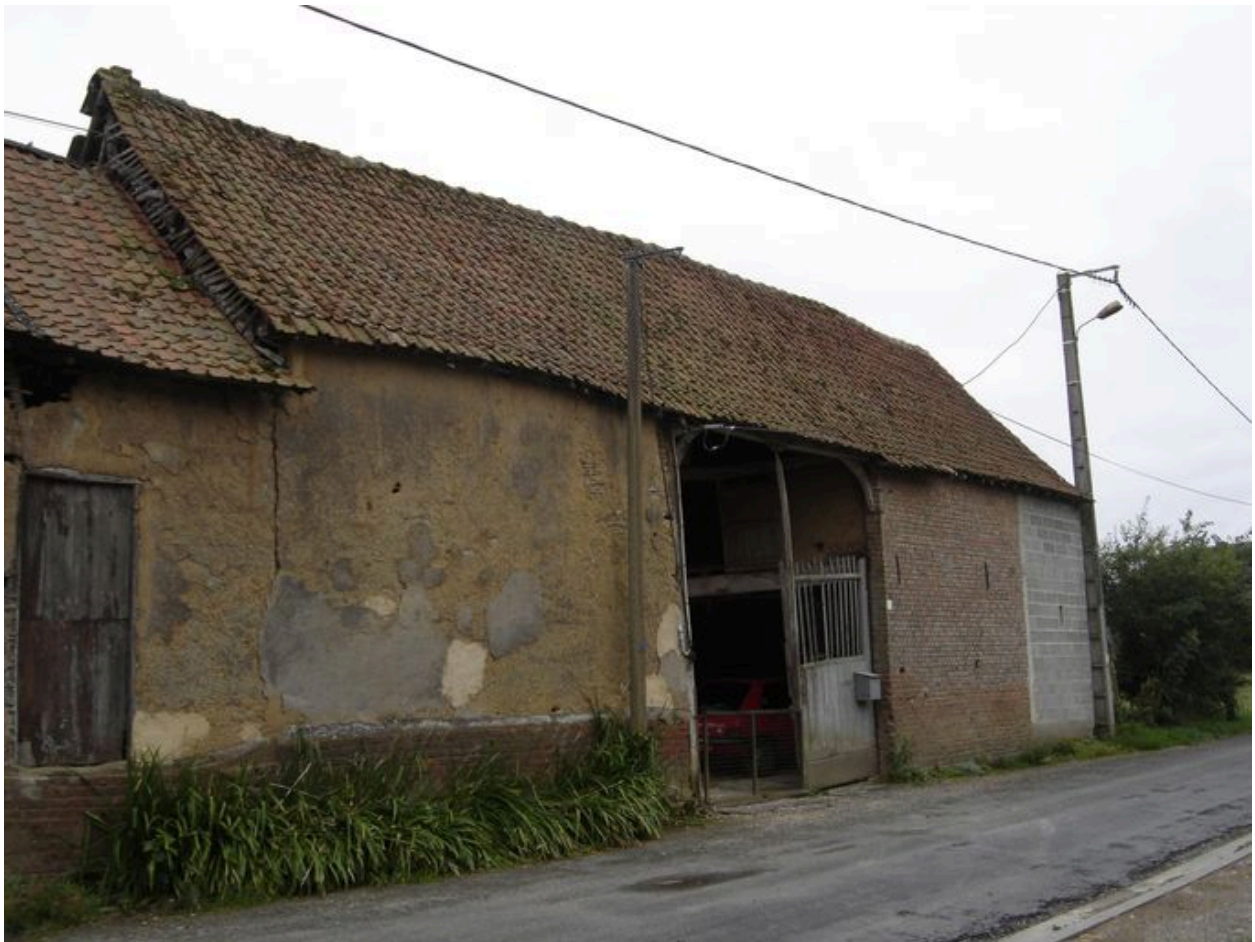
Vue générale de la grange sur rue et du passage couvert.
