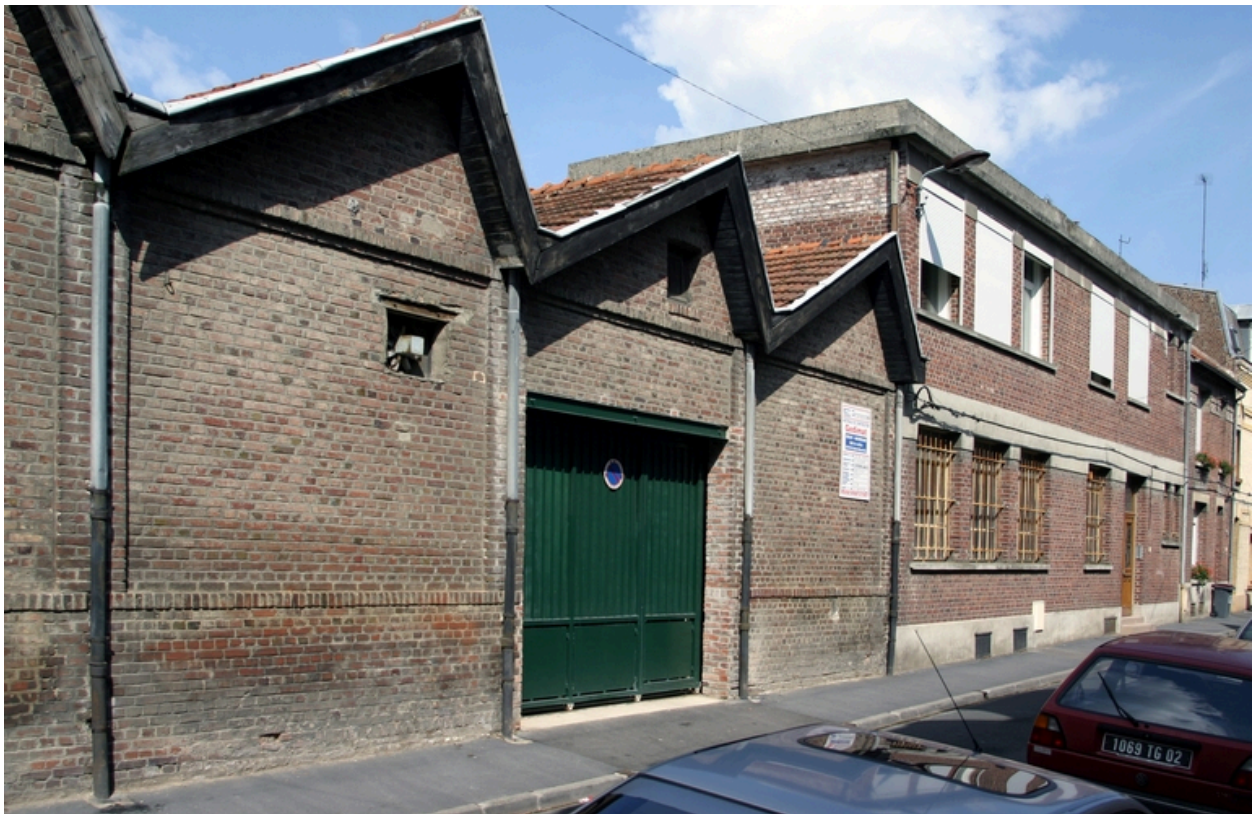
Façade antérieure de l'usine : à gauche, couverts de sheds, les ateliers de 1922, à droite, sur deux niveaux, les ateliers agrandis en 1946.
