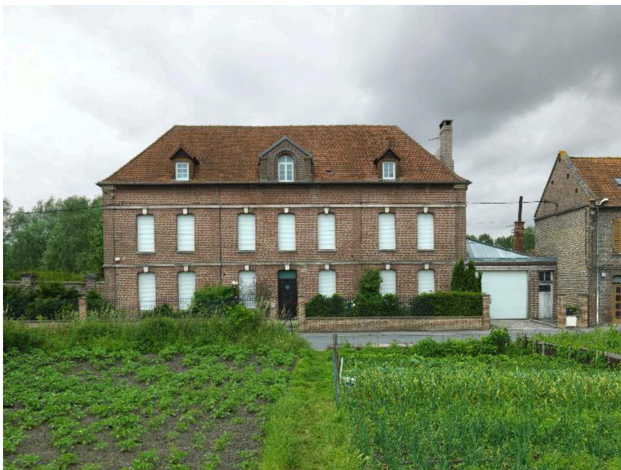
Vue d'ensemble de la façade sur rue.
