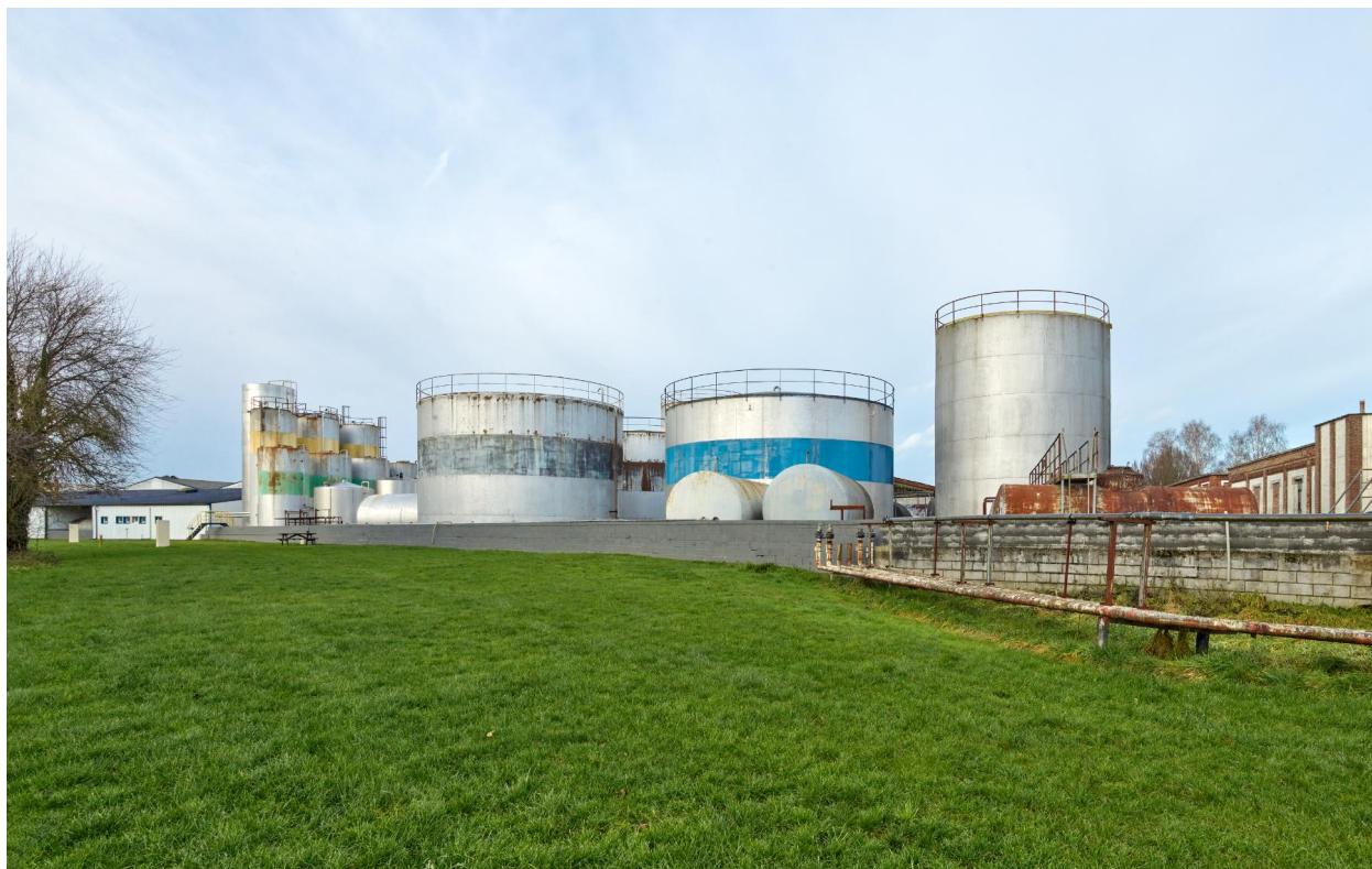
Vue d'ensemble sud du site industriel Acia, développé après 1984.
