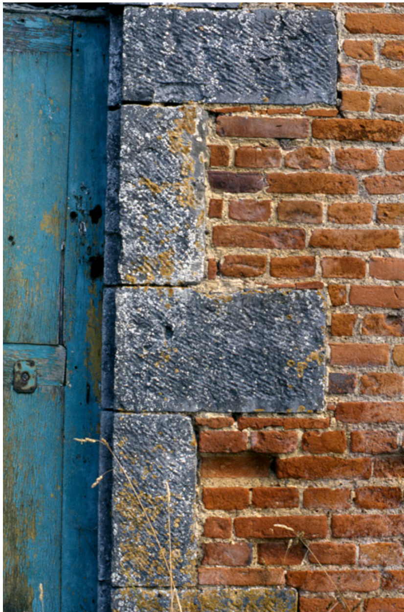
Barzy-en-Thiérache, ferme (repérée), 38 Grande-Rue : détail des matériaux de gros-oeuvre du logis, près de la porte datée 1686.
