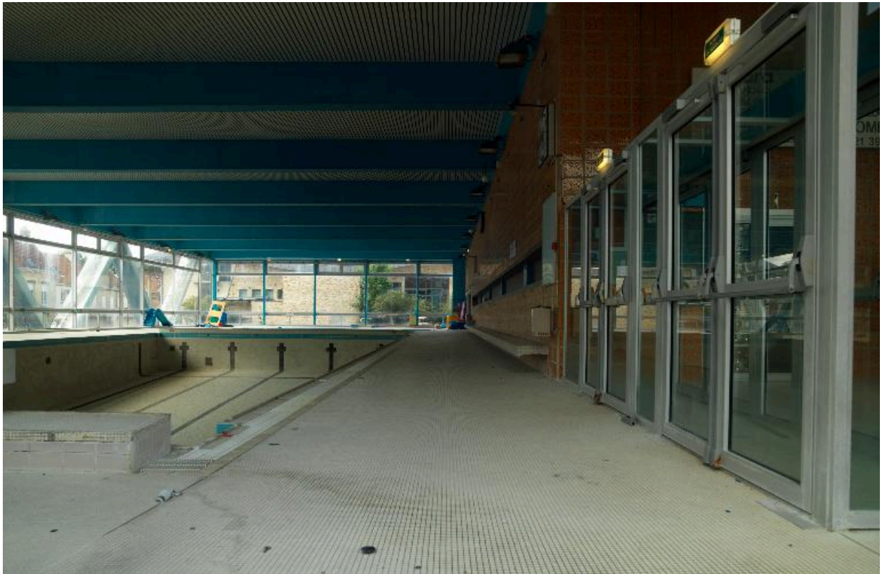
Vue générale du bassin sportif et des plages, côté hall d'entrée.
