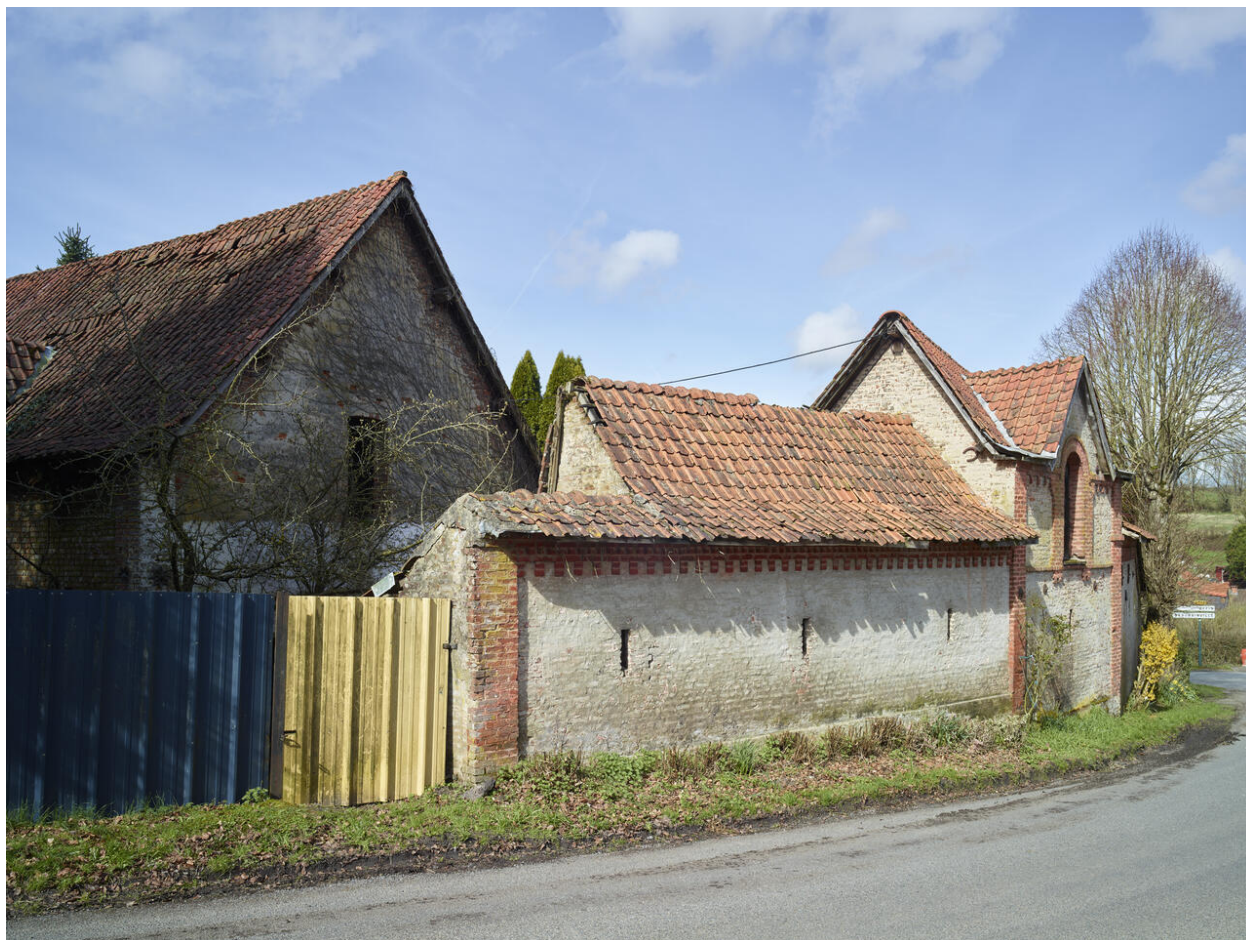
Vue partielle des bâtiments agricoles.
