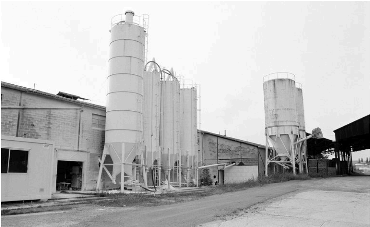
Silos et réservoirs d'eau.
