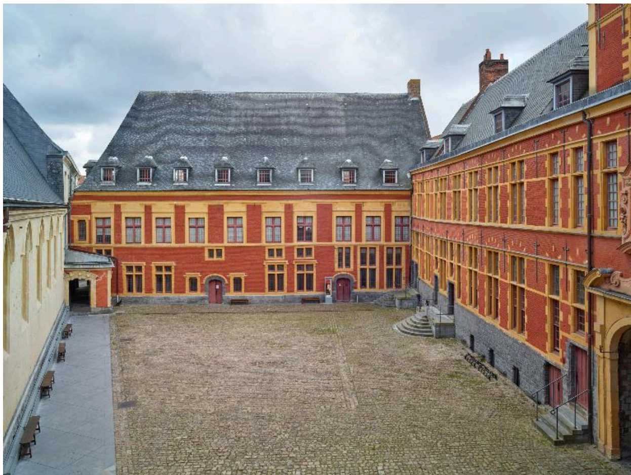
Cour d'honneur, vue générale en regardant vers le bâtiment de la communauté religieuse fermant le côté est de la cour.
