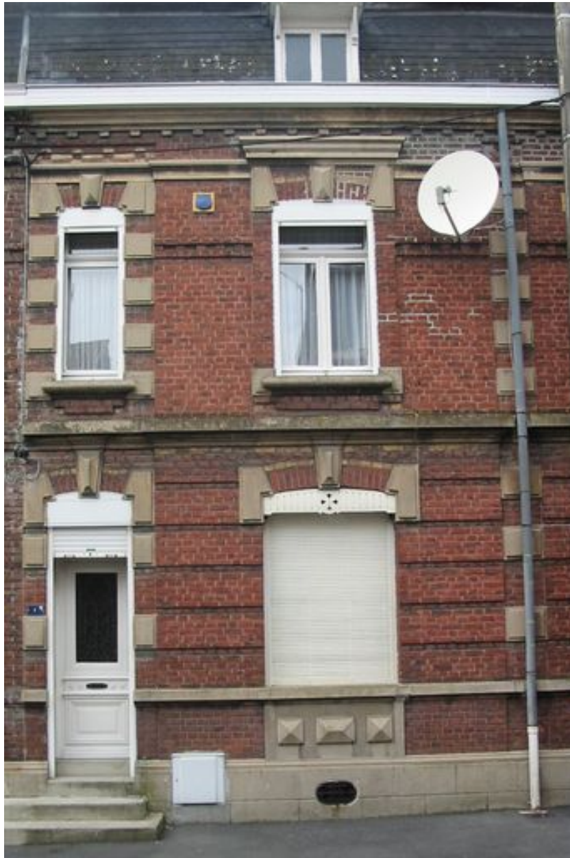
Rang nord-ouest : maison n° 7.
