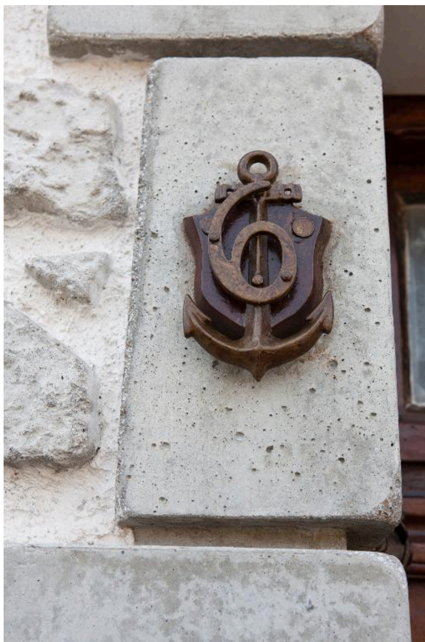
Maconnerie, détail d'un fer d'ancrage.
