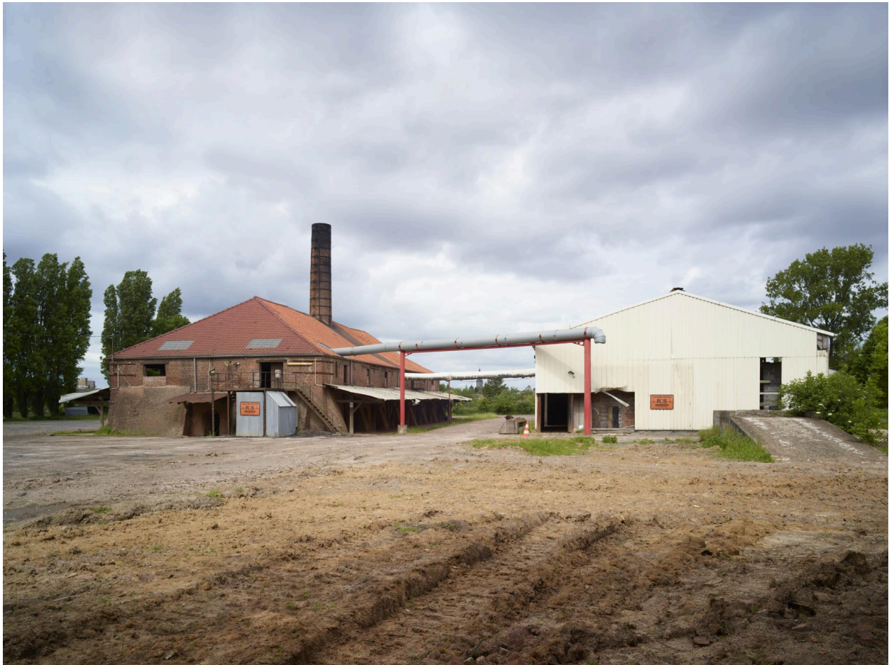
Vue prise vers l'ouest de la briqueterie (à gauche) et du hangar des séchoirs (étuves) depuis l'accès vers les séchoirs à air libre.
