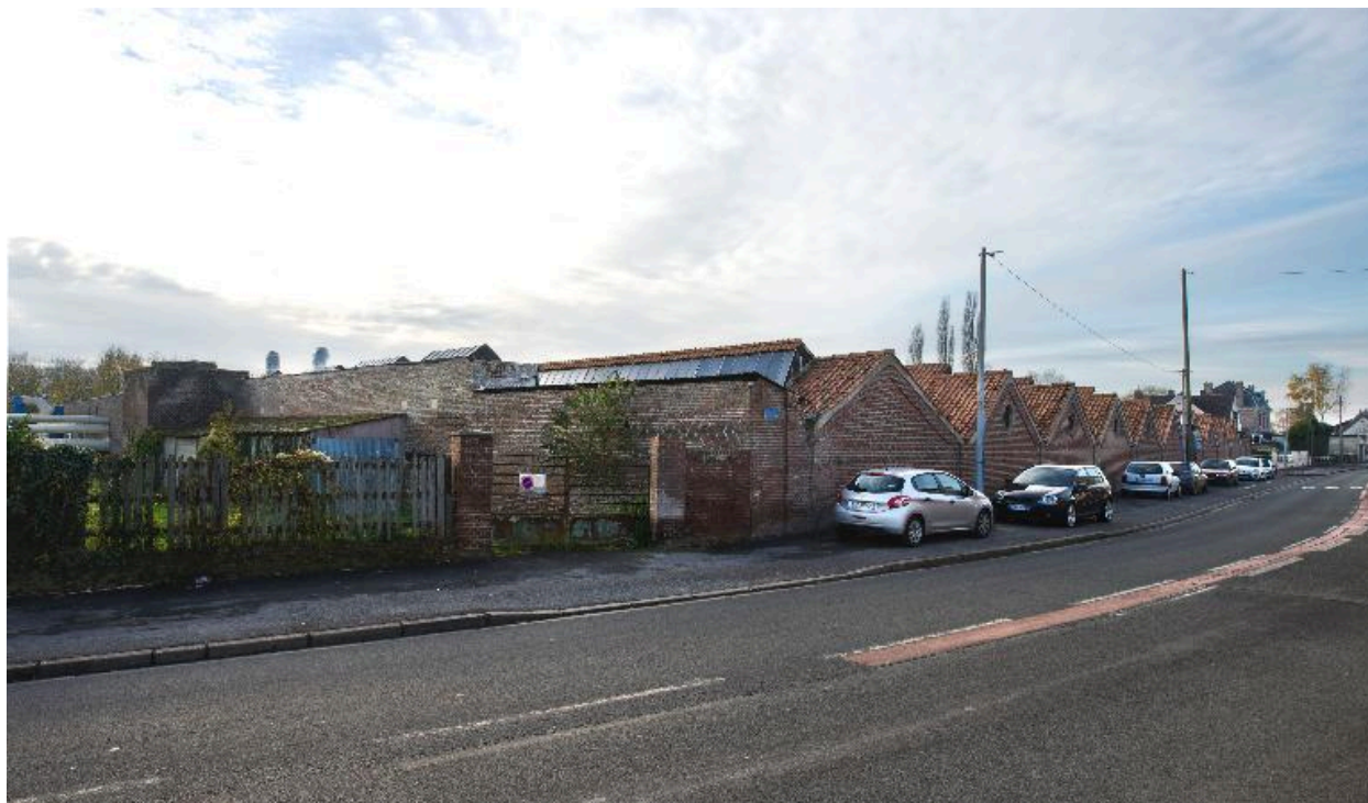
Façade sur rue de l'ancienne filature.
