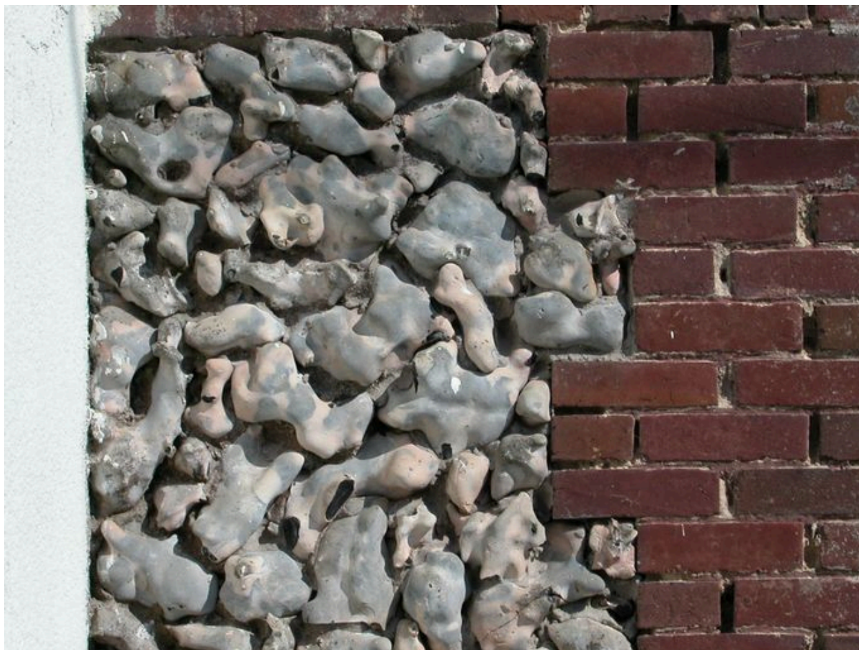
Détail du parement de silex du soubassement.
