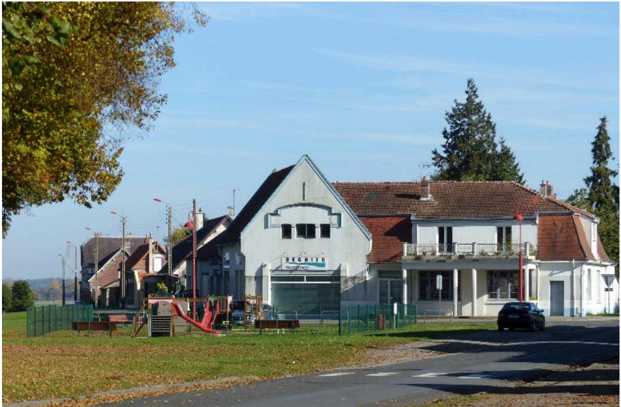
Maisons, rive sud de l'avenue.
