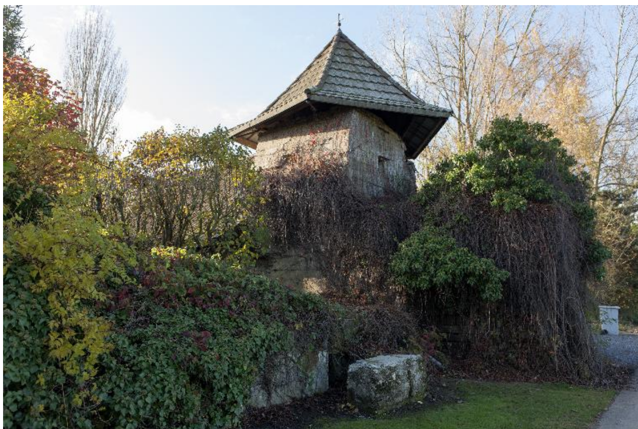
Vue générale, vers le nord-ouest
