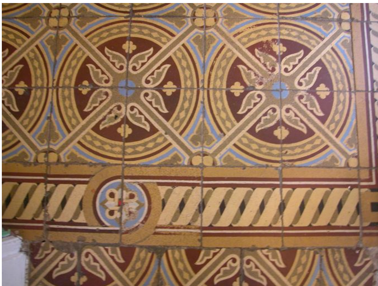
Détail des carreaux de sol du vestibule.
