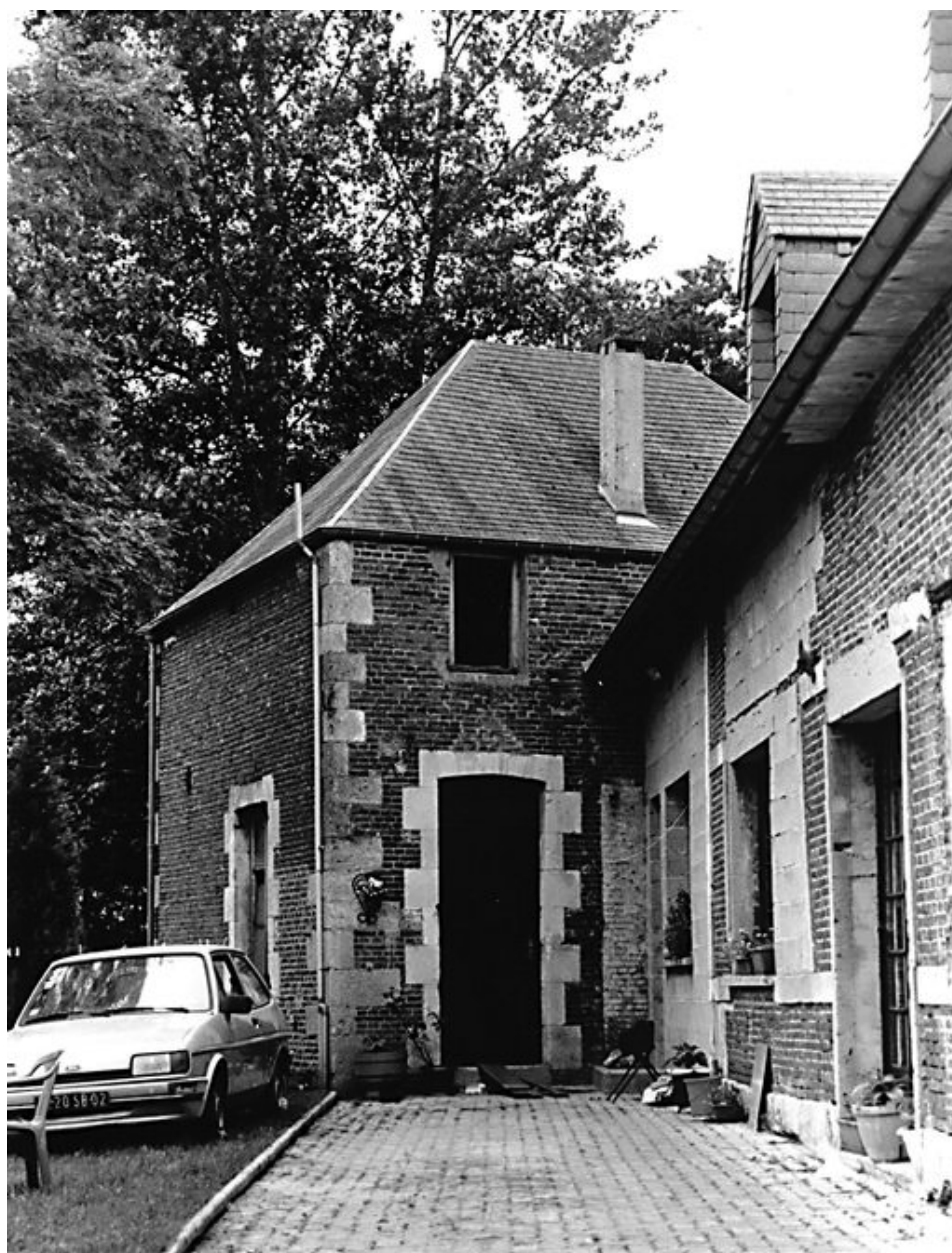
Logis et tour du moulin, 4 ruelle du Château.
