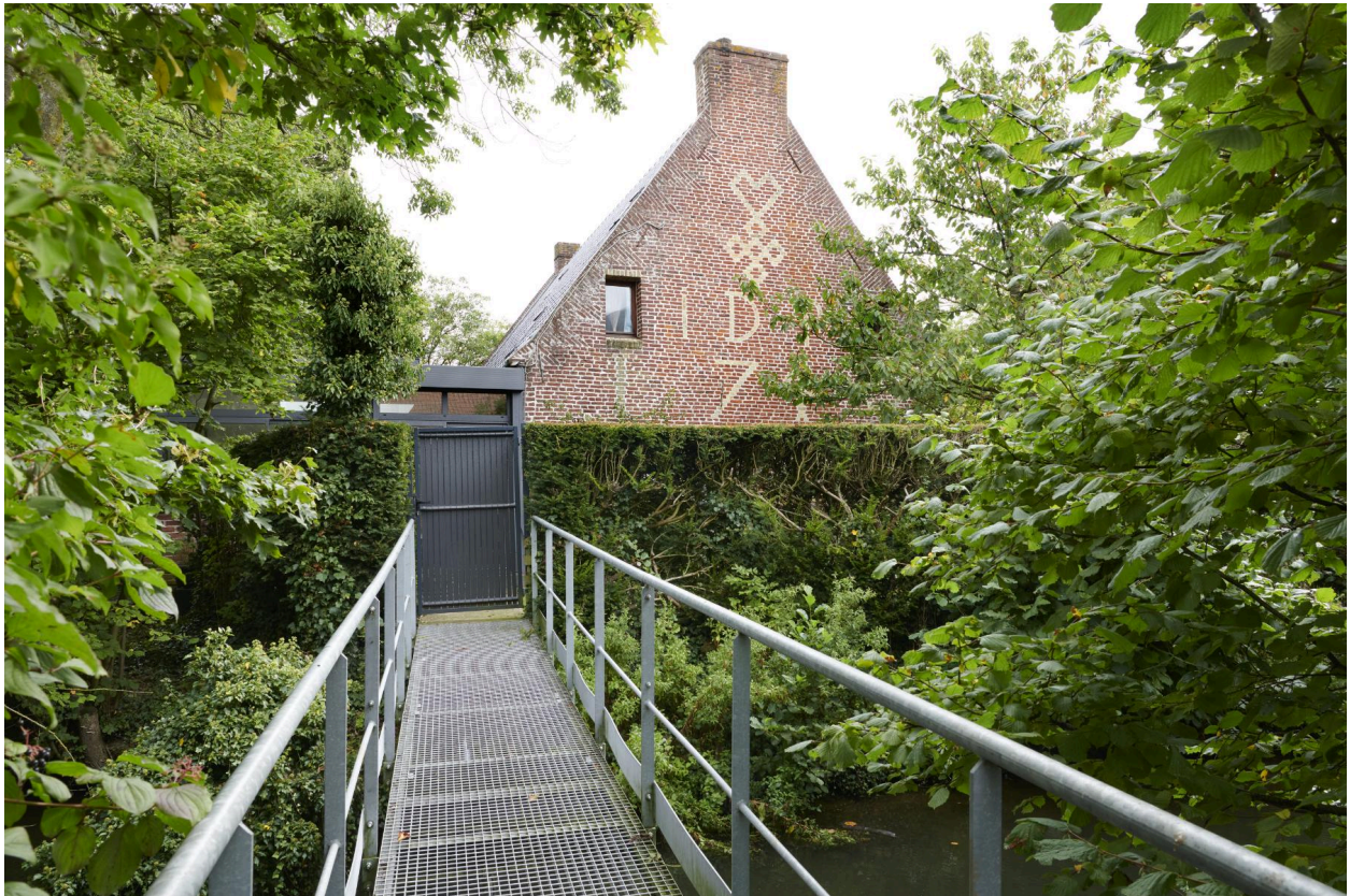
Passerelle enjambant le fossé en eau de la propriété. Pignon ouest.
