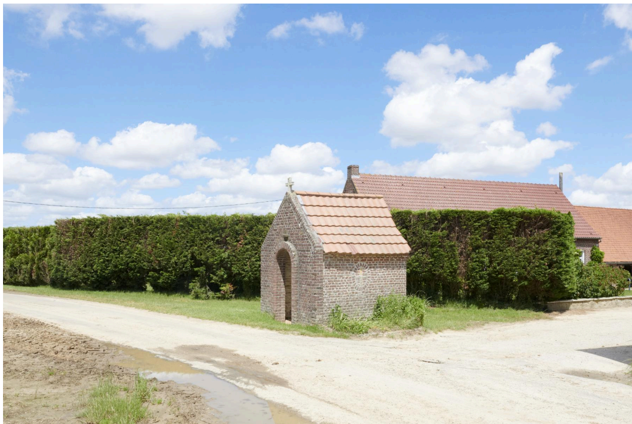
Vue générale de la chapelle.
