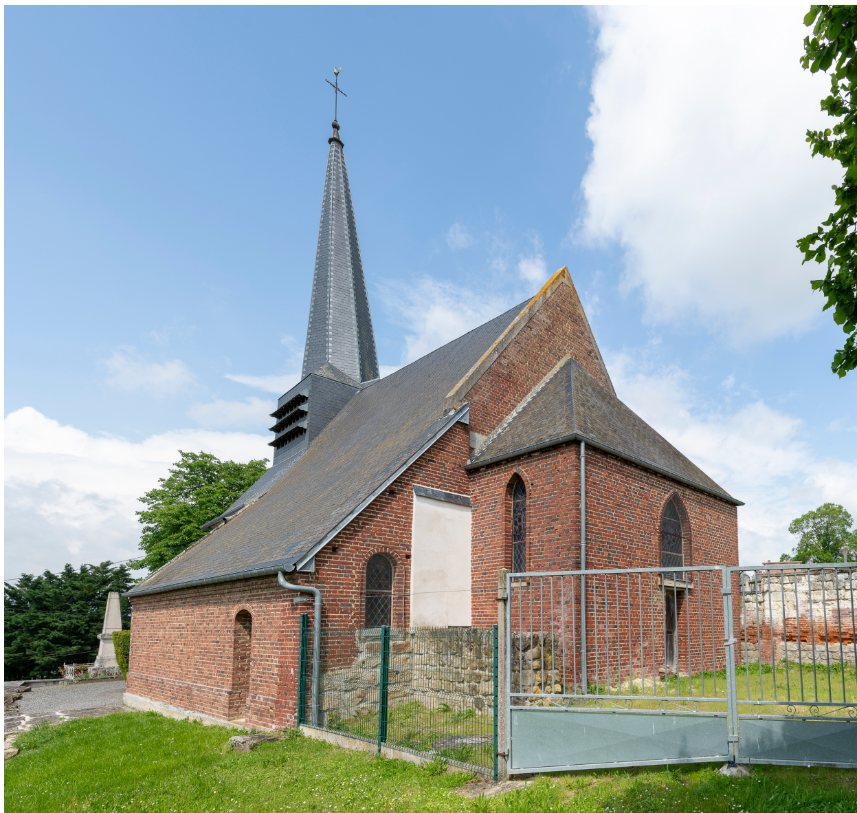
Vue depuis le sud-est.
