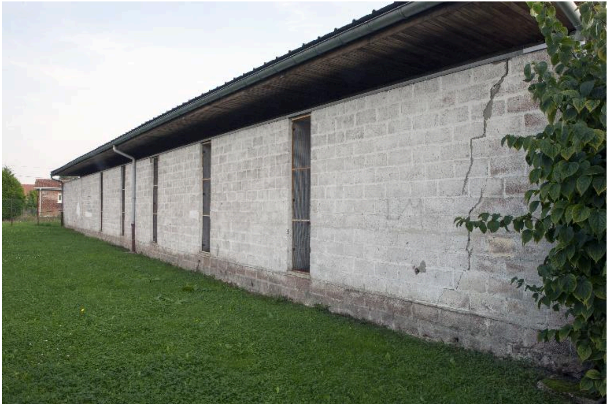
Élévation du flanc gauche de la chapelle.
