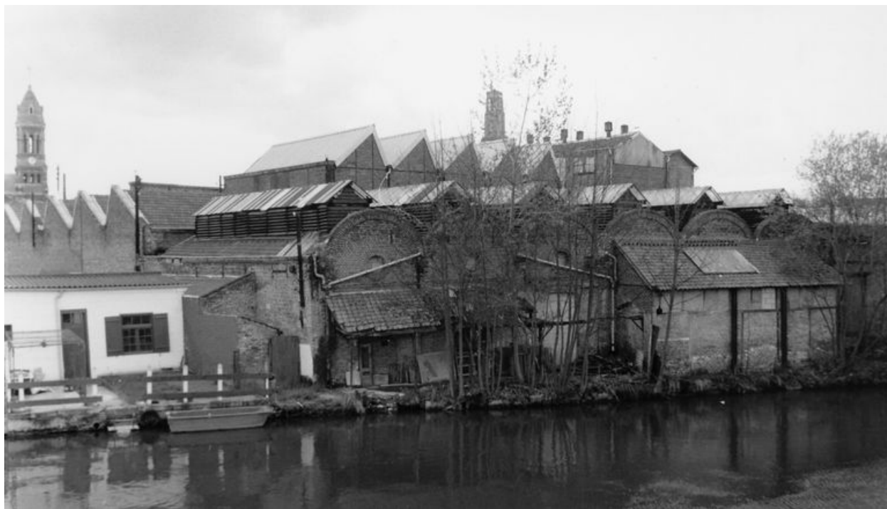
Vue de situation depuis le nord.
