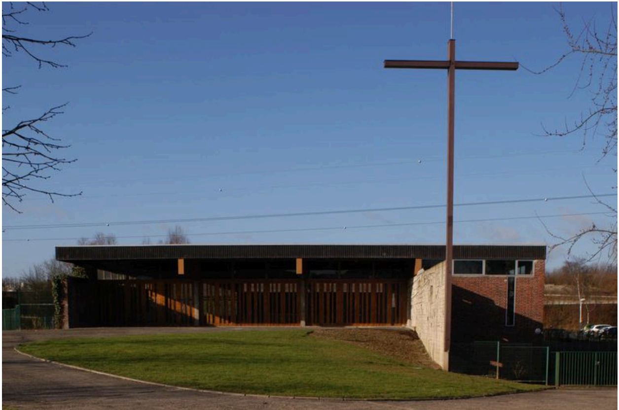
Amiens. Eglise Saint-Paul (Bernard Bougeault architecte).
