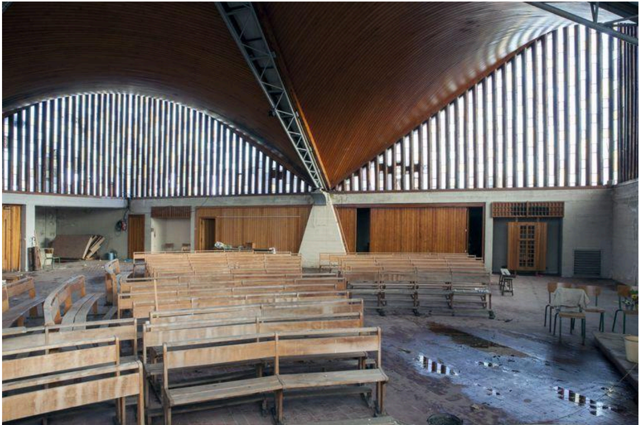
Vue générale depuis l'autel vers le flanc nord.
