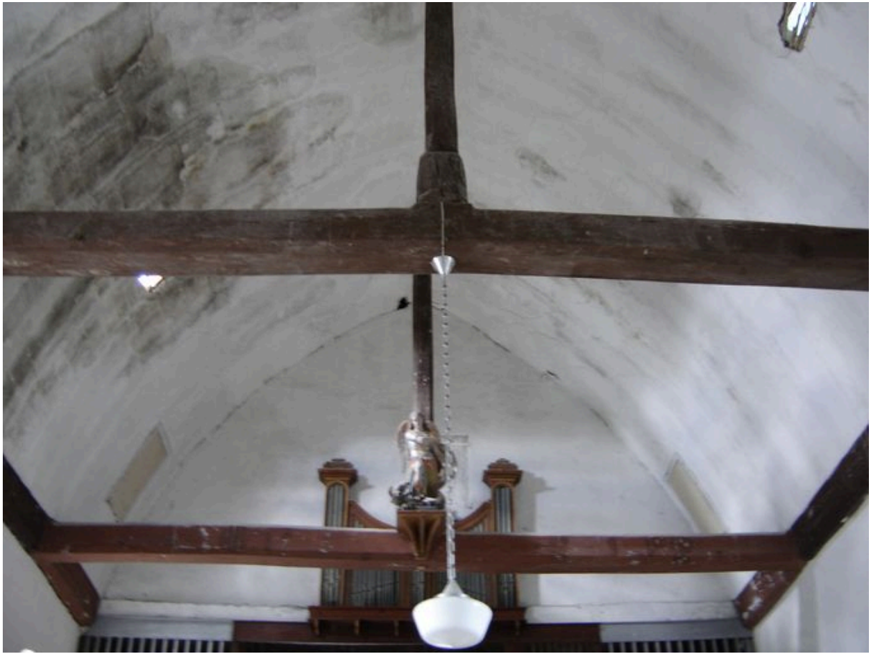
Vue des fermes de la charpente.
